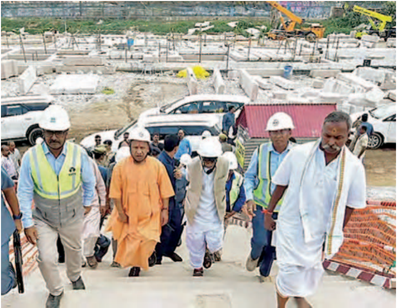
అయోధ్యలో కొనసాగుతున్న రామమందిర నిర్మాణం పనులు శనివారం పరిశీలించిన యుపి సీఎం యోగి ఆదిత్యనాథ్
